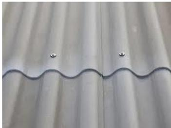
Da für diese Dachform generell keine zugelassene Montagekomponente existiert, achten Sie bei der Montage unbedingt auf die Verwendung einer mindestens 1mm starken Kalotte, damit das Projekt statisch berechnet werden kann.
