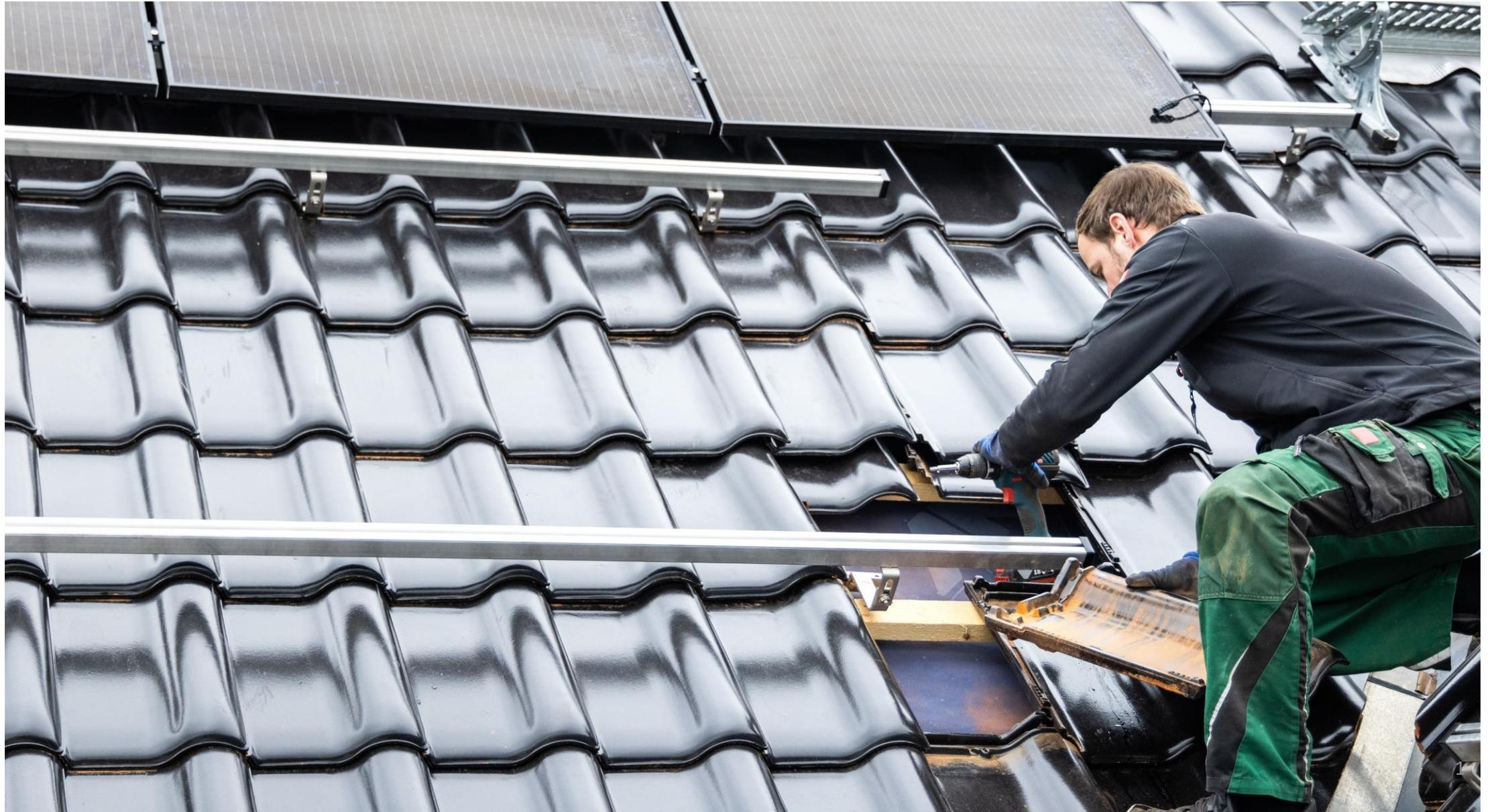
Die folgenden Montagehinweise befassen sich mit der **Montage der PROFINESS-Montagesysteme für Schrägdächer mit Dachziegeln/Dachsteinen.**
